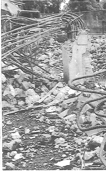
▲圖美中工藝教室如鋼牆鐵壁，柱子充滿著又粗又窄的鋼筋。
